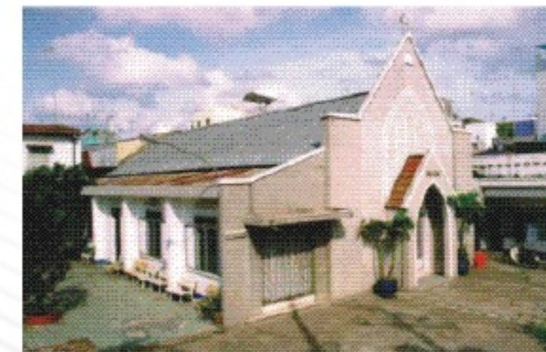
Từ tháng 03.1989 Nới rộng cánh gà bên trái Nhà Thờ để có thêm chỗ ngồi trong Nhà Thờ - đúc máng xối 02 bên mái - thay các cửa sổ gỗ bằng cửa nhôm kính - nâng nền, lát gạch mới.
