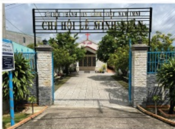
Ngày 13.04.2013 Việc xây dựng Điểm Nhóm Lê Minh Xuân được hoàn tất.
